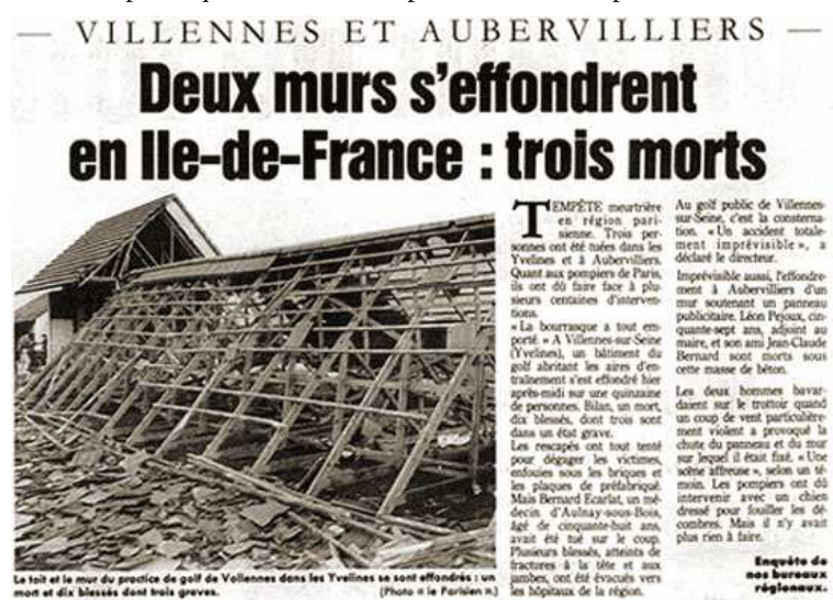
Le toit et le mur du garage de golf de Villennes dans les Yvelines se sont effondrés : un mort et dix blessés dont trois graves. (Photo : le Parisien).
